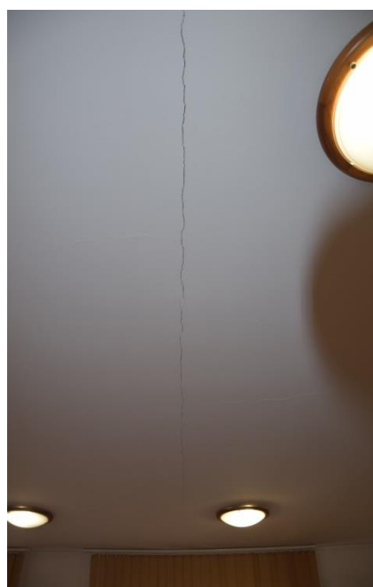
Sala sesyjna - ściany i sufit z widocznymi rysami
