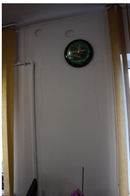
Sala sesyjna - ściany i sufit z widocznymi rysami
