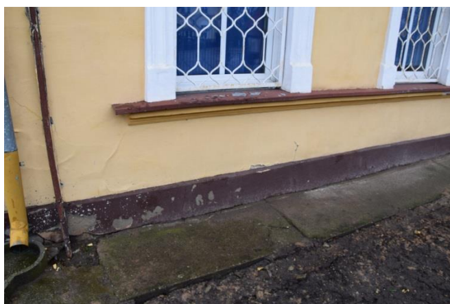
Opaska betonowa budynku
