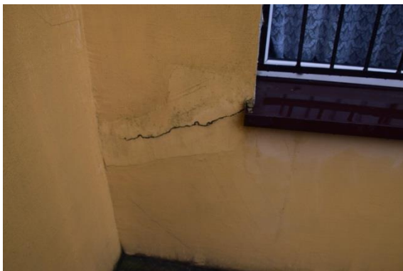
Uszkodzona izolacja termiczna ścian zewnętrznych – Bryła B
