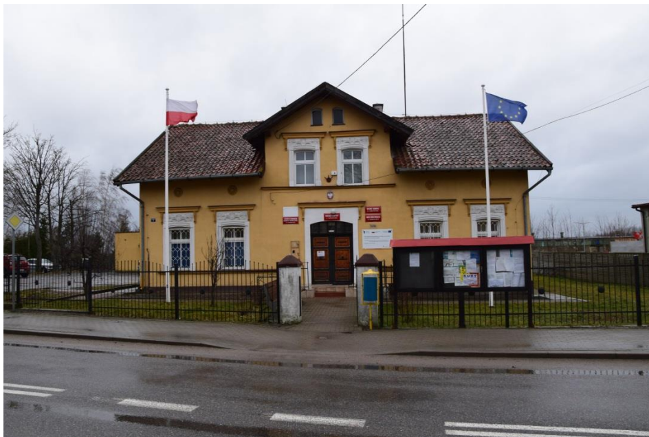
Elewacja frontowa - wejściowa południowa
