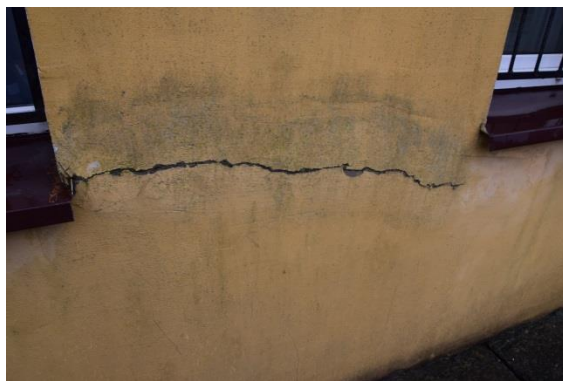
Uszkodzona izolacja termiczna ścian zewnętrznych – Bryła B
